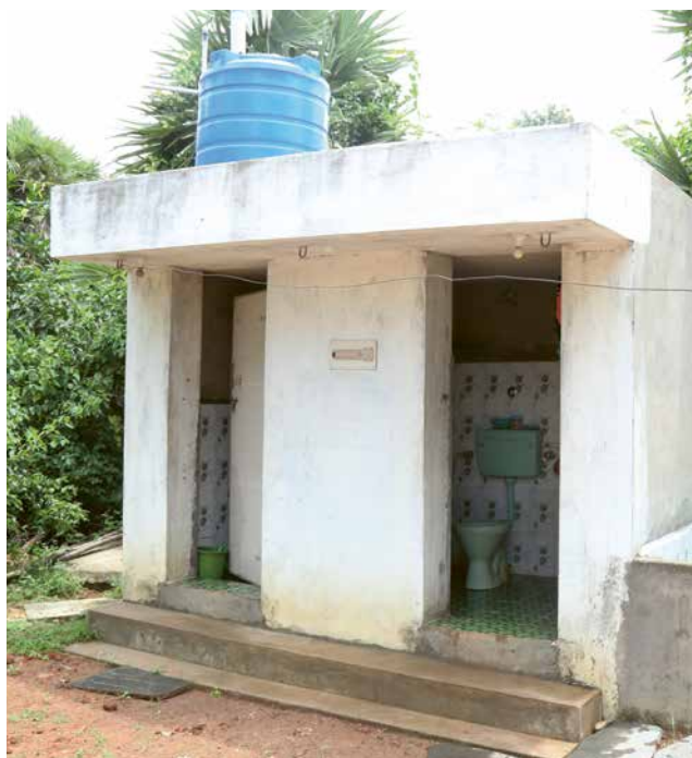
Eine öffentliche Toilette ist ein Segen für die Dorfbewohner: Rechts im Becken ist Wasser zum Händewaschen, das Wasser für die Toilette wird oben in den Wassertank gepumpt.
