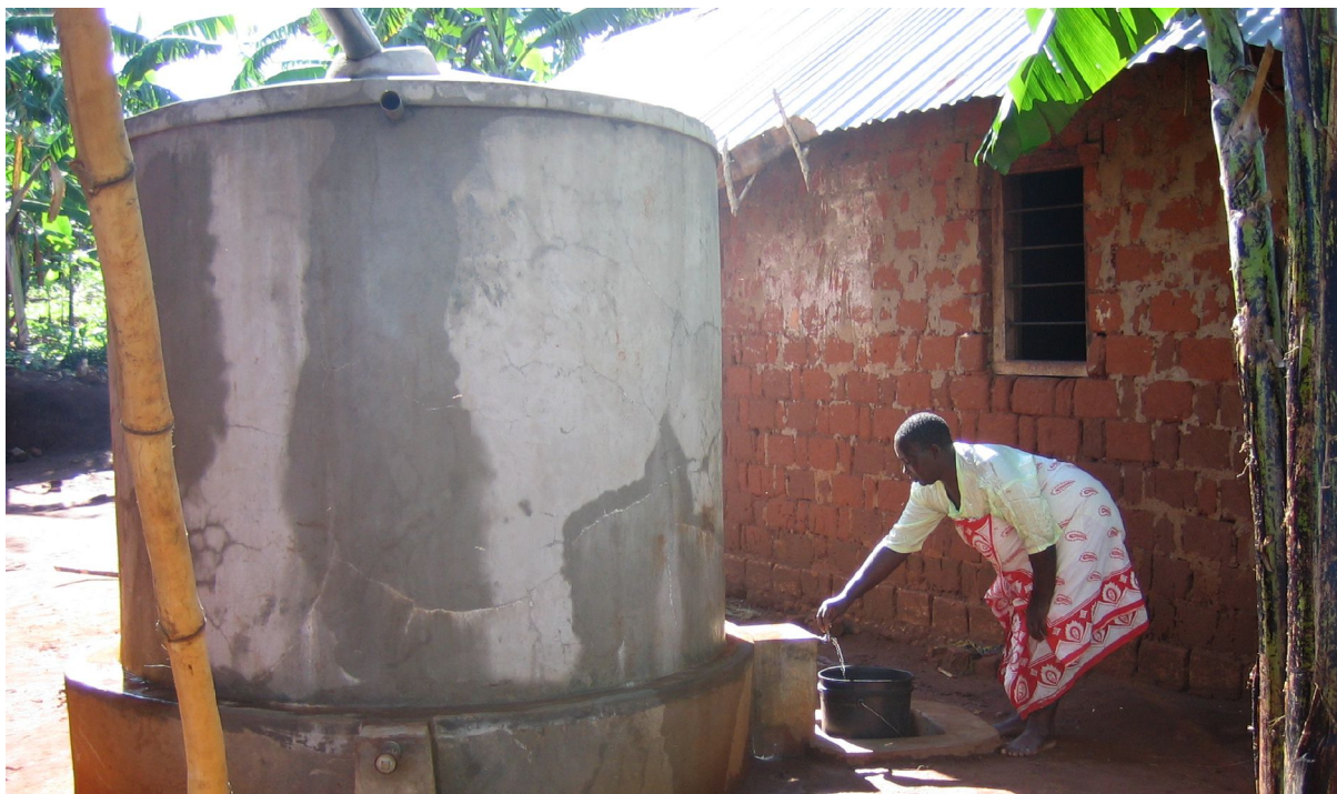
Abb. 1 Wasser, dass sich in den Zisternen speichern lässt, ist sauber und verursacht keine Krankheiten.
