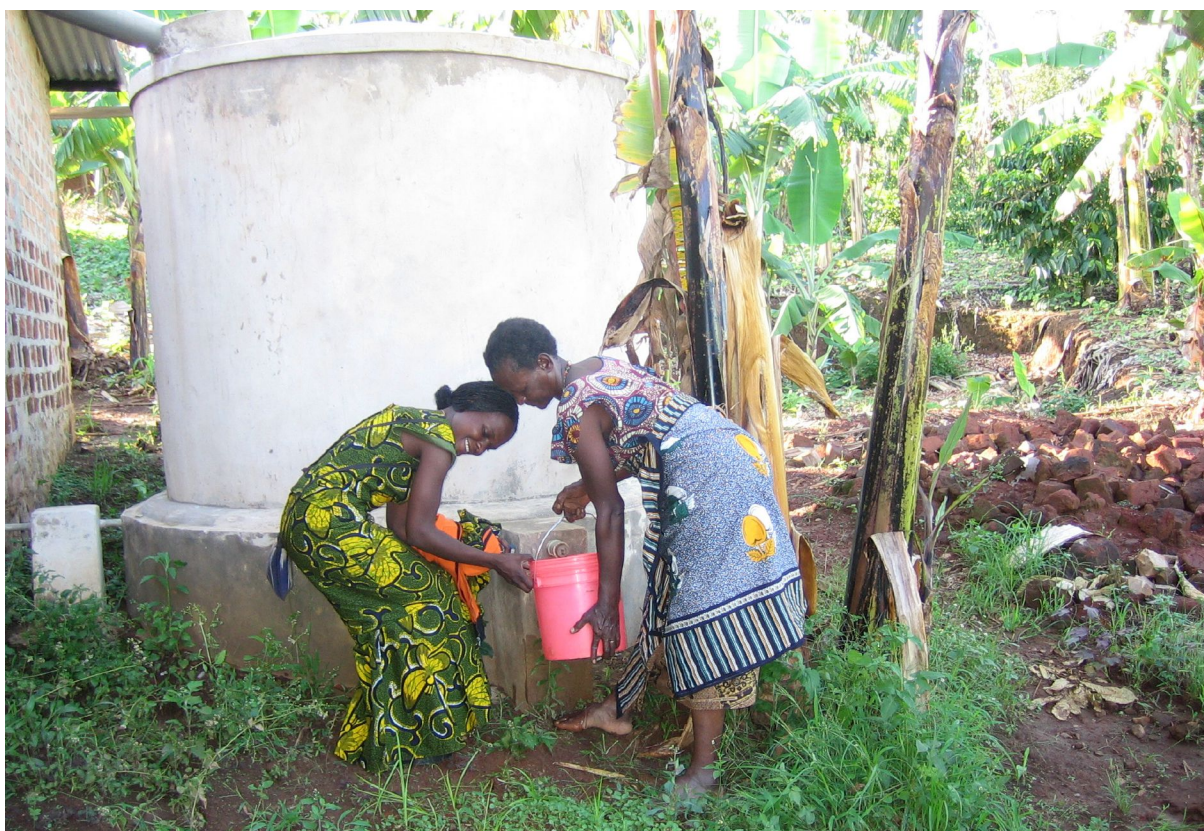
Abb. 2 Der Bau von Brunnen und Zisternen verschafft den Dorfbewohnern Zugang zu sauberem Wasser.
