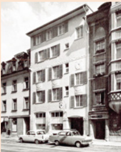
Die Erweiterung des Dachstocks und die Renovation der Fassade verwandelten die Confiserie ins heutige Gesellenhaus.
